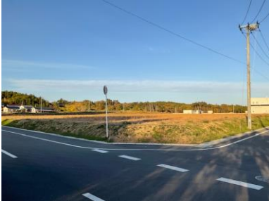
3月 着工（北産業団地）
